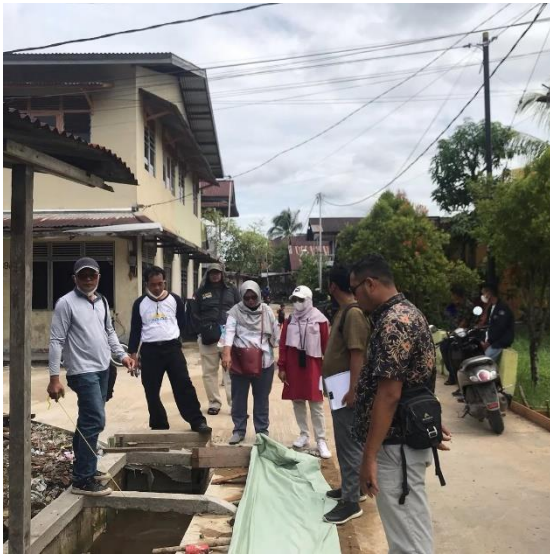
Gambar 5. Pelaksanaan Pembangunan Jalan lingkungan dan Monitoring dari Dinas PRKP Sumber: Dokumentasi Pribadi
