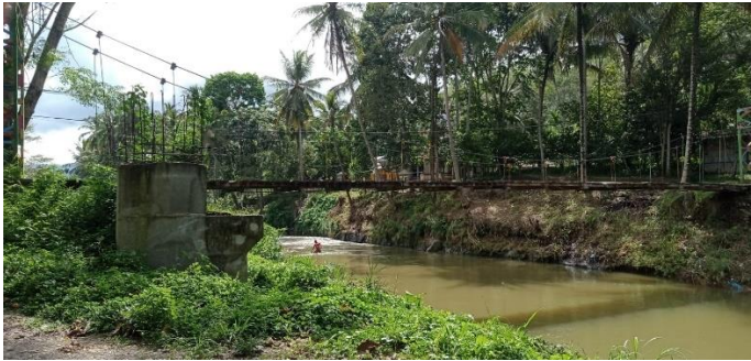
Gambar 1. Pembangunan pondasi jembatan di Jorong Lombah, Nagari Sungai Rimbang dengan menggunakan dana desa tahun 2021
